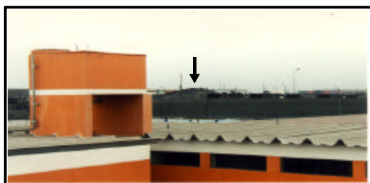
Figura 3. Vista de la azotea de la escuela María Reiche. Barrio de Puerto Nuevo, provincia Constitucional del Callao, Perú 1998.
